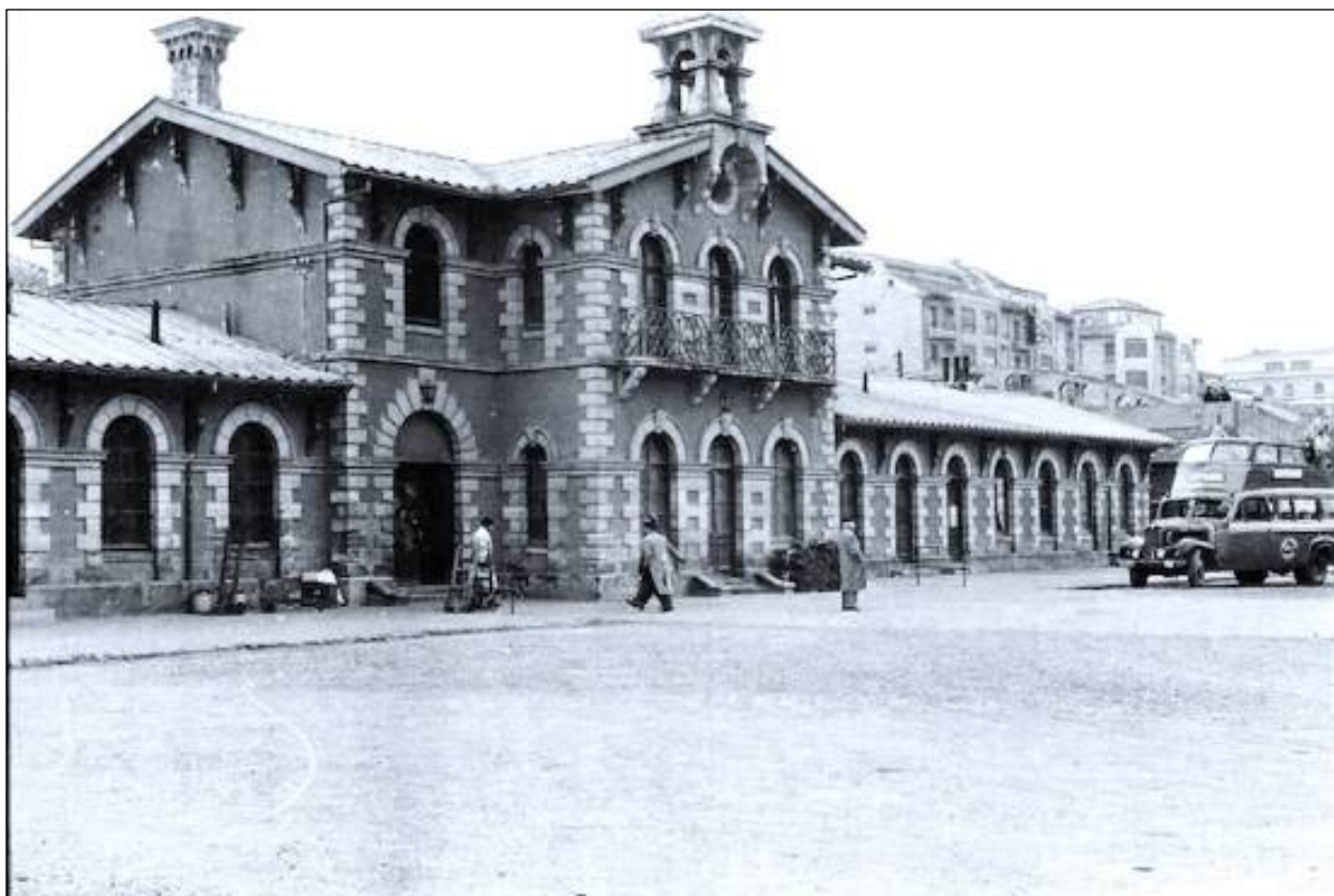
La Estación Fuenmayor
